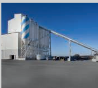
Tårnanlæg med 2 stk. 6000 l blandere for produktion af transportbeton.
