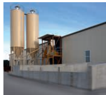
Elementfabrik med Haarup blandeanlæg og jordsiloer.
