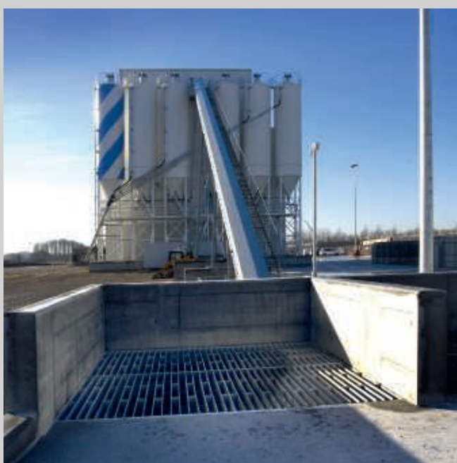
Aftipningssilo med kørbær gitterrist.
