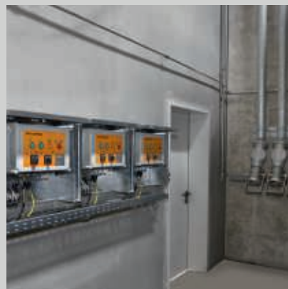
Haarup Silo Control sikrer mod overfyldning og overtryk i siloen.
