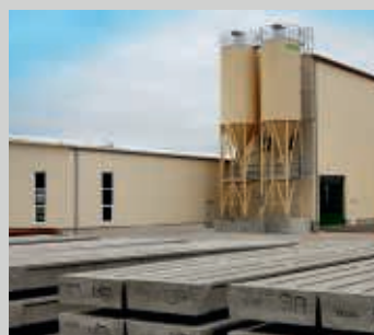
Spaltefabrik med komplet Haarup doserings- og blande- anlæg.
