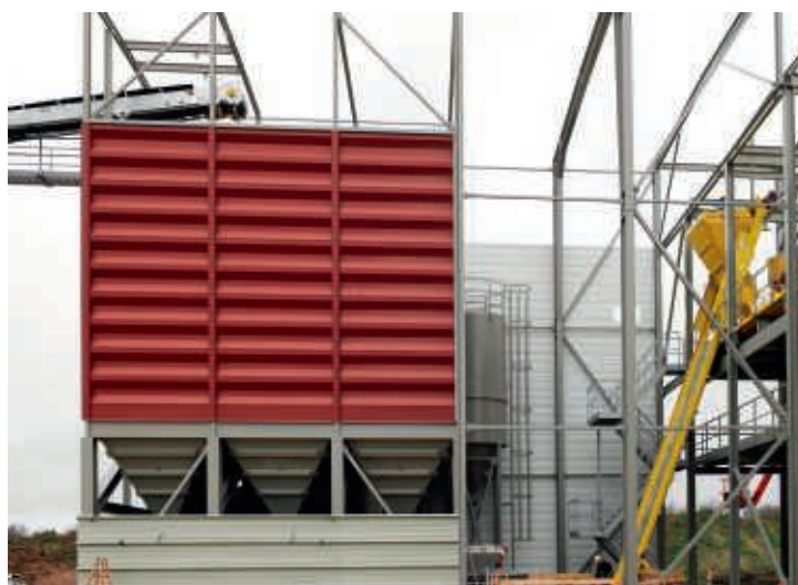
Højsiloanlæg med ifyldningsystem.
