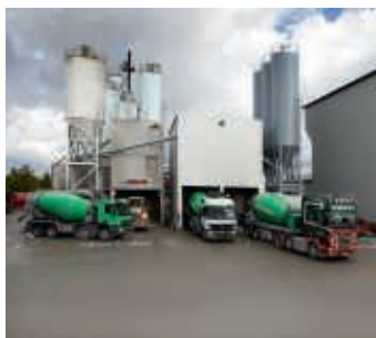
Modernisering af eksisterende transportbetonanlæg med Haarup 6000 l blander.
