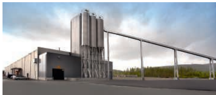
Tårnanlæg med 2 stk. 2250 l blandere for produktion af sveller.
